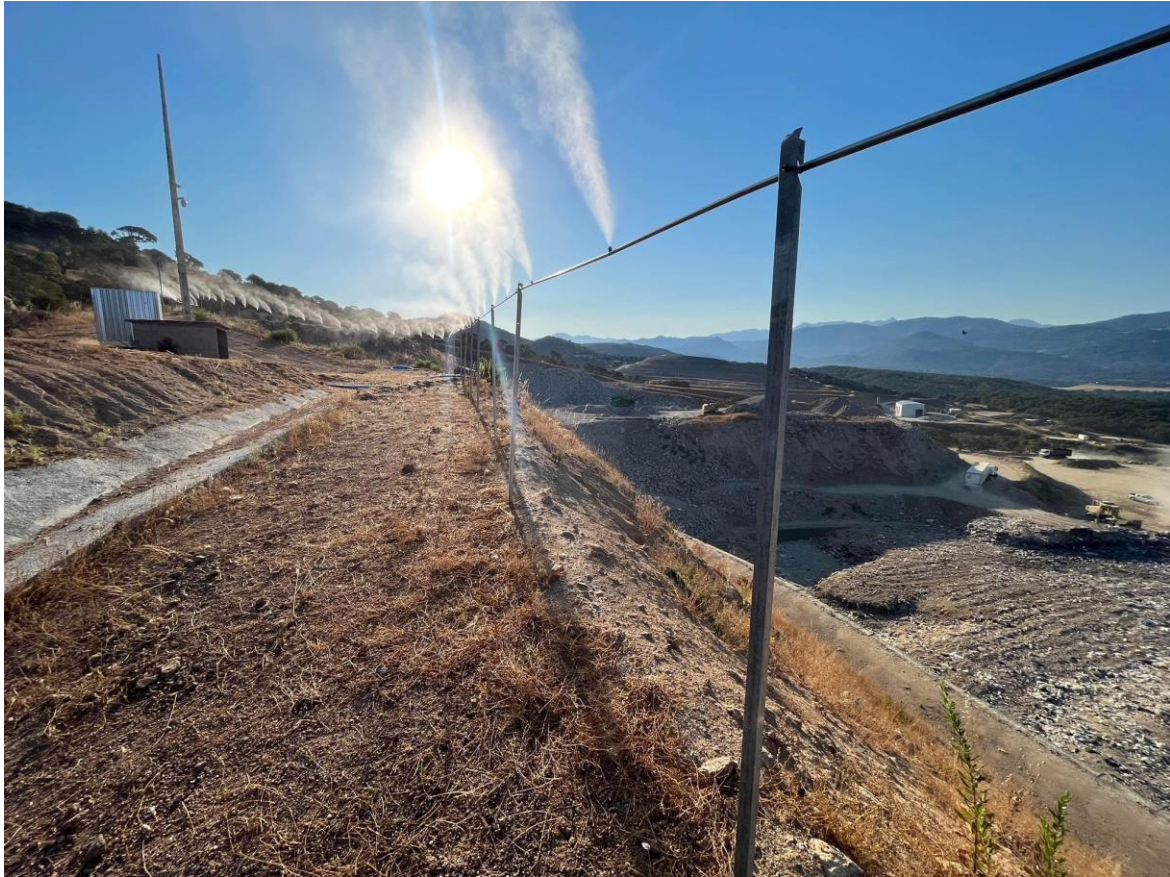
Rampe haute-pression en inox 316
